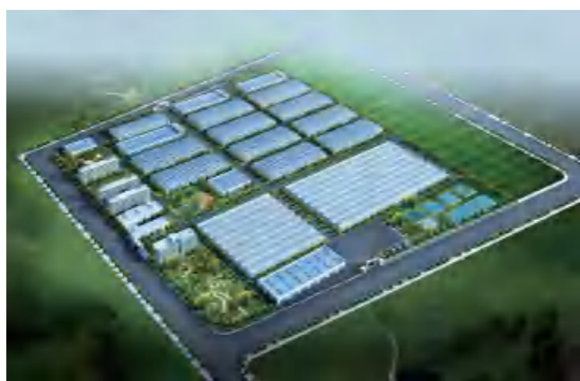
湖南省源宏实业发展有限公司常德经编产业工业园项目
