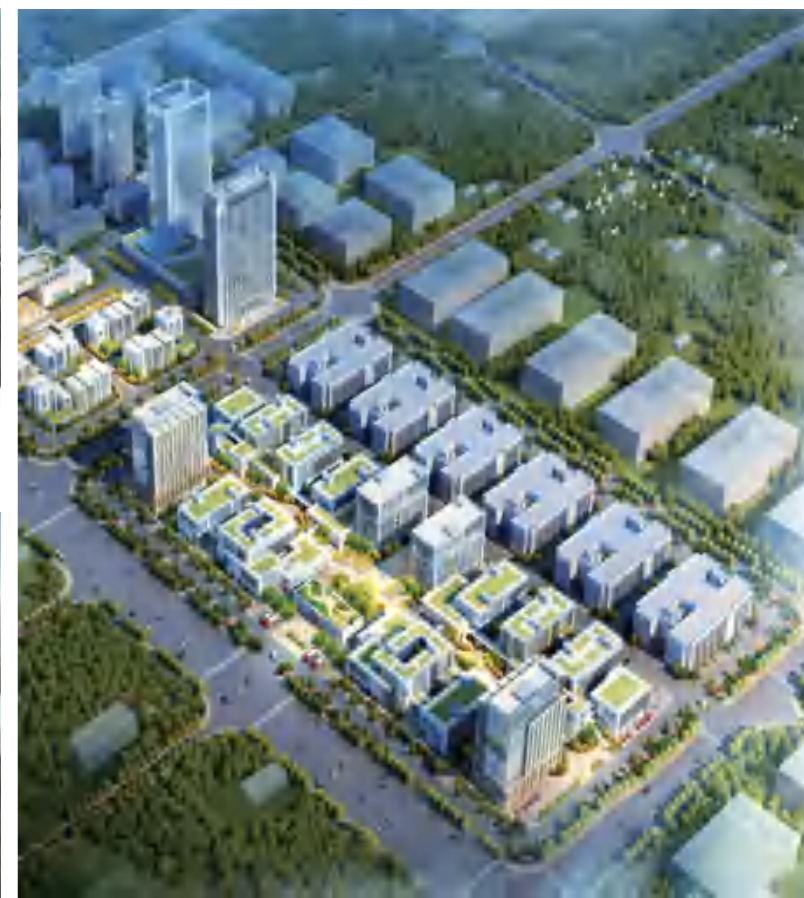
常德经开区德谷科创城项目
