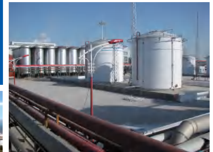
吉林吉安新能源集团有限公司总溶剂建设工程
