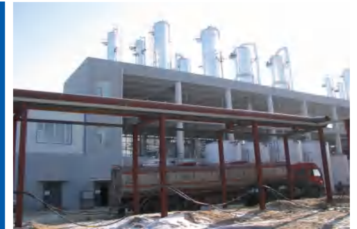
罗马尼亚无水乙醇建设工程
