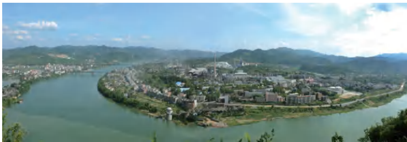
湖南省湘维有限公司 我公司承担牵切纱、无纺布、聚乙烯醇、电石炉等工程设计
