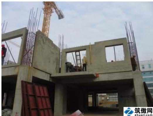
先安装法：又称“香港工法”，主体结构施工的同时，将预制承重墙板、非承重墙板同时起吊-安装就位，通过现浇混凝土互相连接为一体。对主体结构的施工精度及预制墙板的加工精度均要求不高，可最大限度地消除施工误差的影响，不存在明缝，基本不会造成墙体渗漏。非承重墙板一般需要出筋与主体结构相连，制作比较复杂且制作成本稍高。后安装法非承重墙板模具简单但对模具的制作精度要求很高，同时主体结构需要预留埋件其模具制作精度要求同样很高，总体而言，后安装法的费用及对精度的要求均远高于先安装法。
