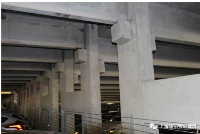
多层装配式建筑：框架(铰接单向梁)-剪力墙，不考虑第二道防线，楼面采用大跨双 T 板或 SP 板。多为干法施工，全预制 PC。充分考虑装配式建筑的特点，抛开现浇混凝土结构的思维模式。
