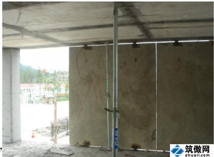
起吊安装与主体结构通过焊接或螺栓连接在一起。对主体结构的施工精度及预制墙板的加工精度要求甚高，且存在明缝。施工不当将有渗漏风险，建筑接缝材料比主体结构使用年限短。日本装配式PC的生产、施工精度。
